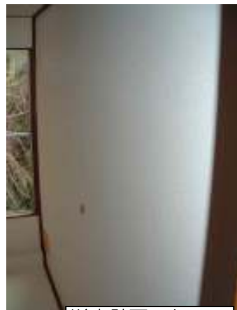
洋室壁面・クロス
