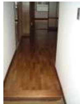
玄関からの通路床・壁
